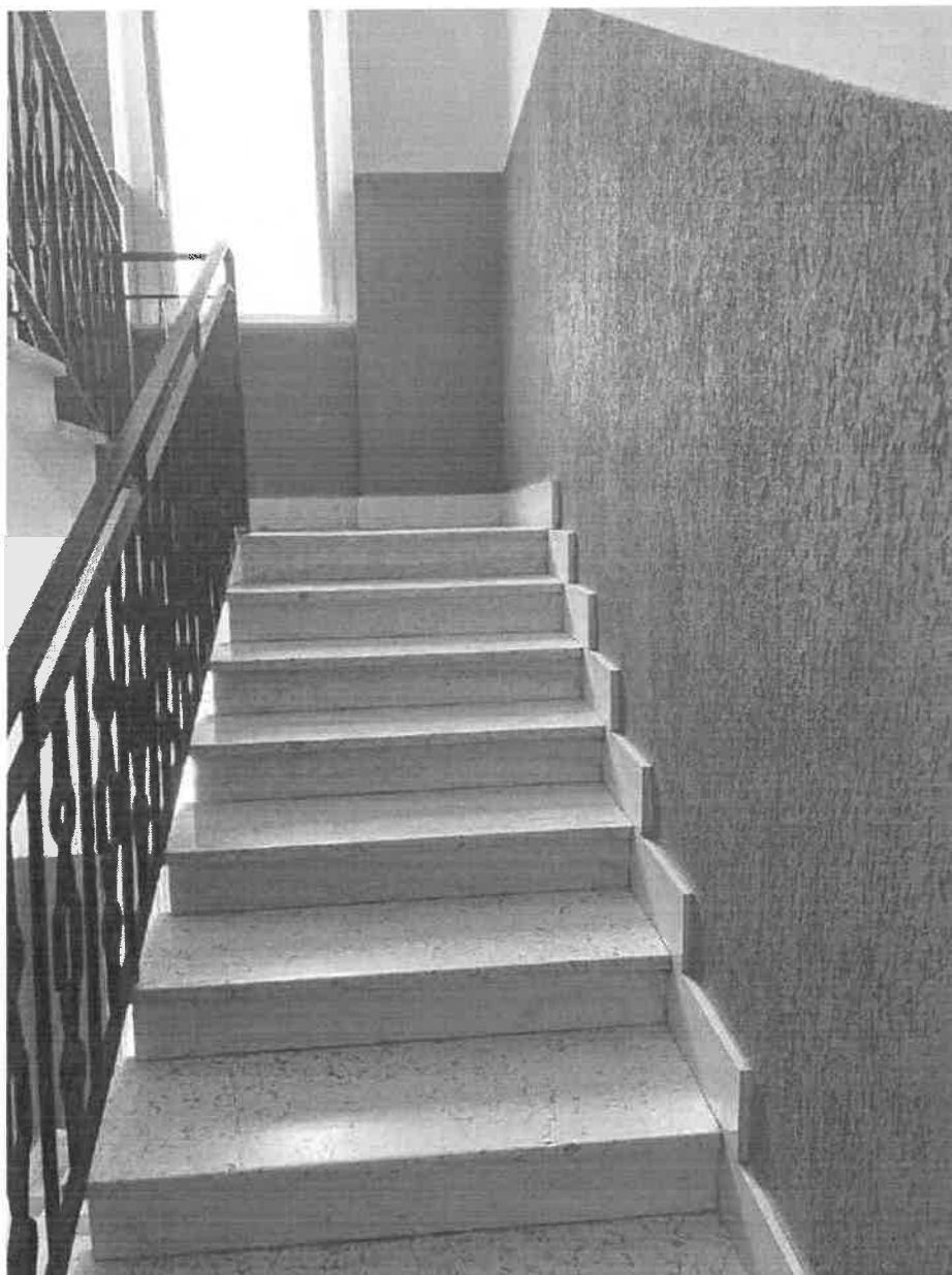
FOTO n. 3 – Vista scala di accesso condominiale –
