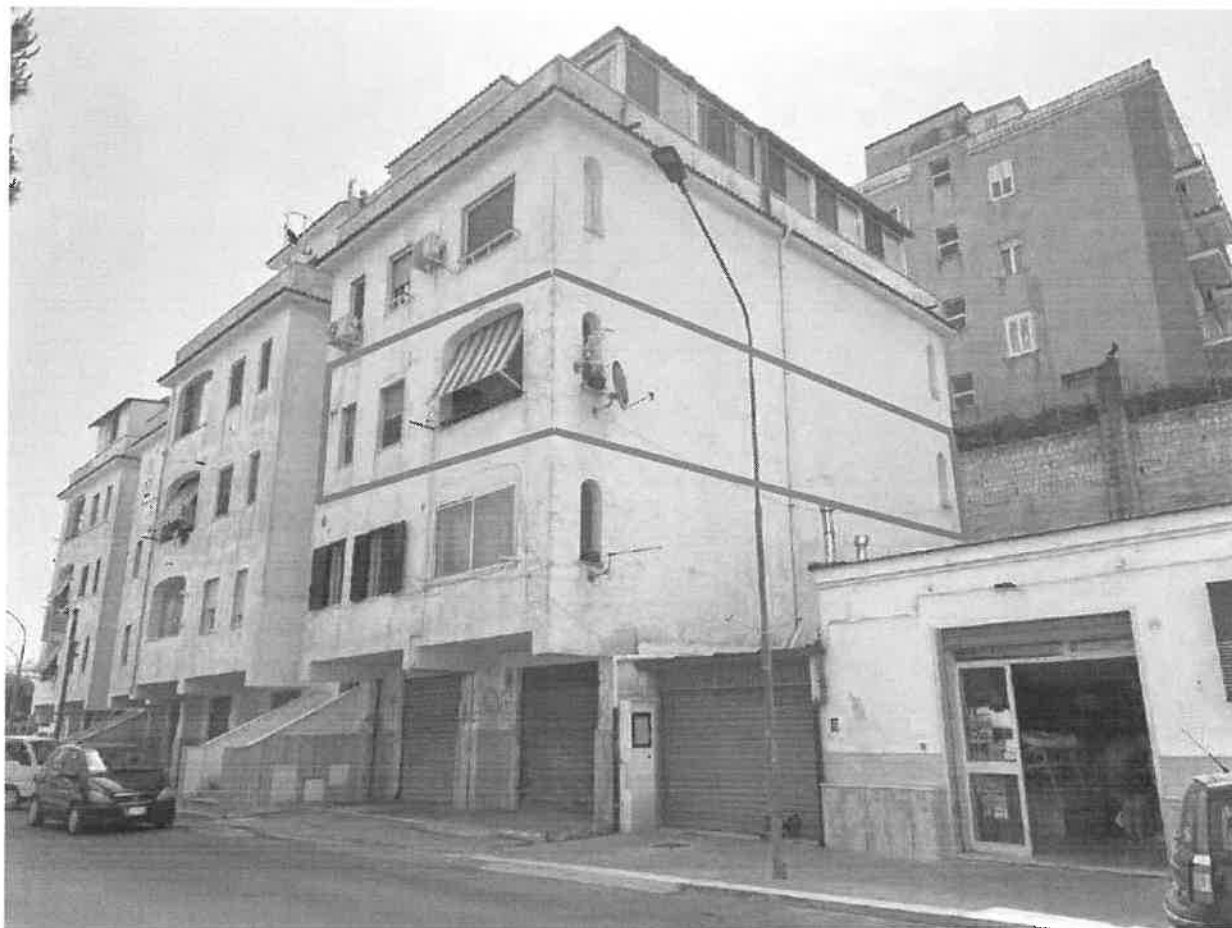
FOTO n. 2 – Vista esterna lotto n.3 -
