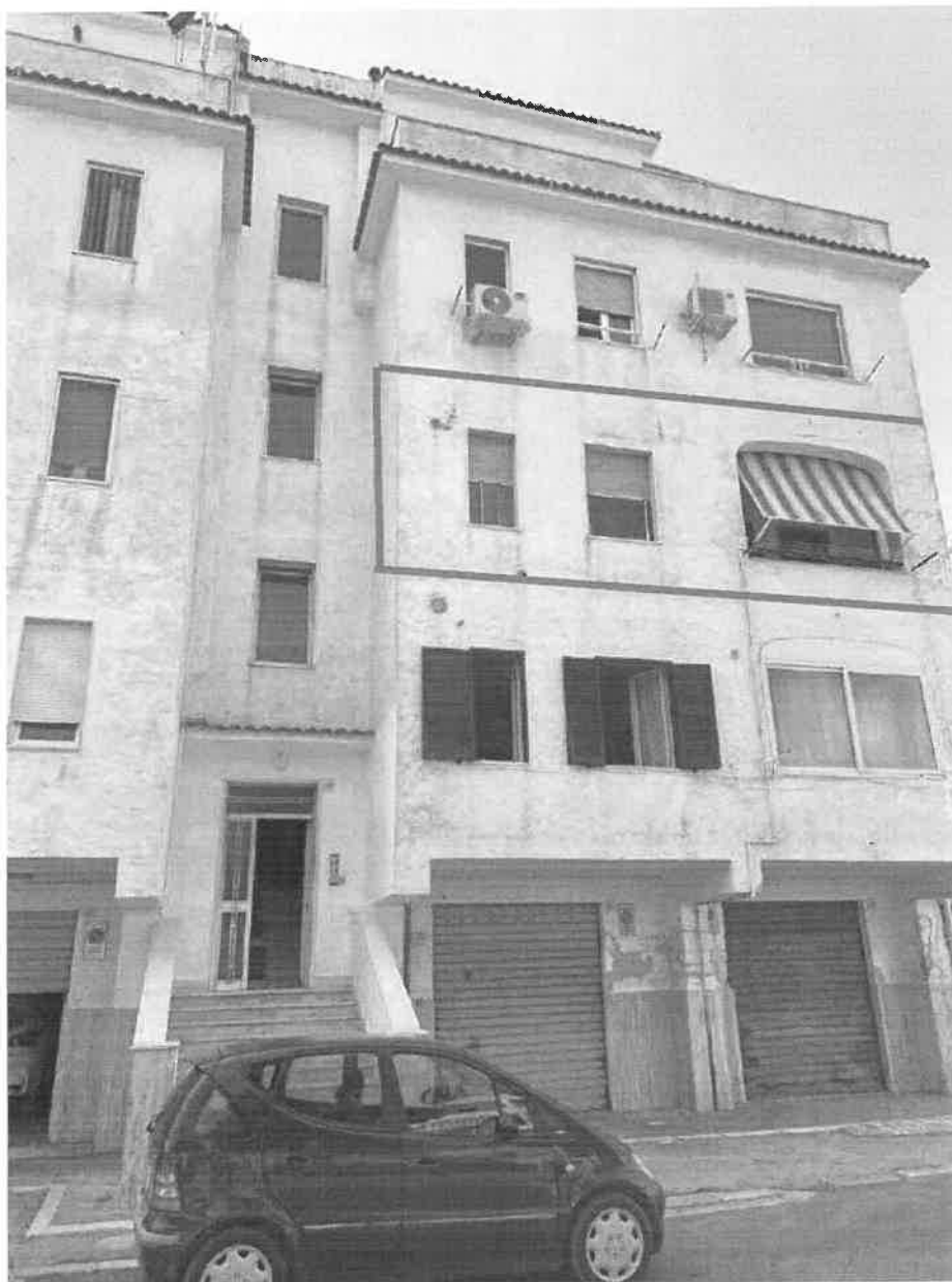
FOTO n. 1 – Vista esterna abitazione lotto n.3 –
